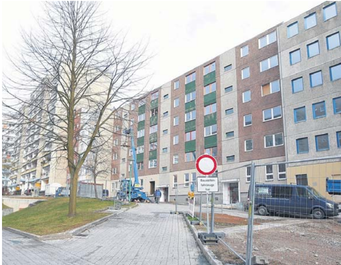
Hier soll es bald gemütlich werden. Die Wohnungsbaugesellschaft saniert diese Blöcke an der Tischendorfstraße 23 bis 31. Der Vermieter plant einige Vierraumwohnungen. Auch die kleinen Wohnungen werden größer. FOTO: ELLEN LIEBNER
